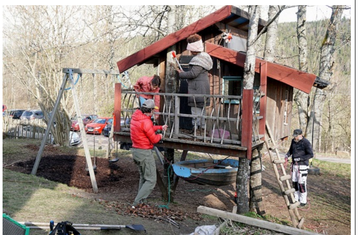
Trehuset får nytt rekkverk
